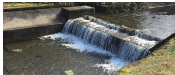
図4 下流にある堰堤
